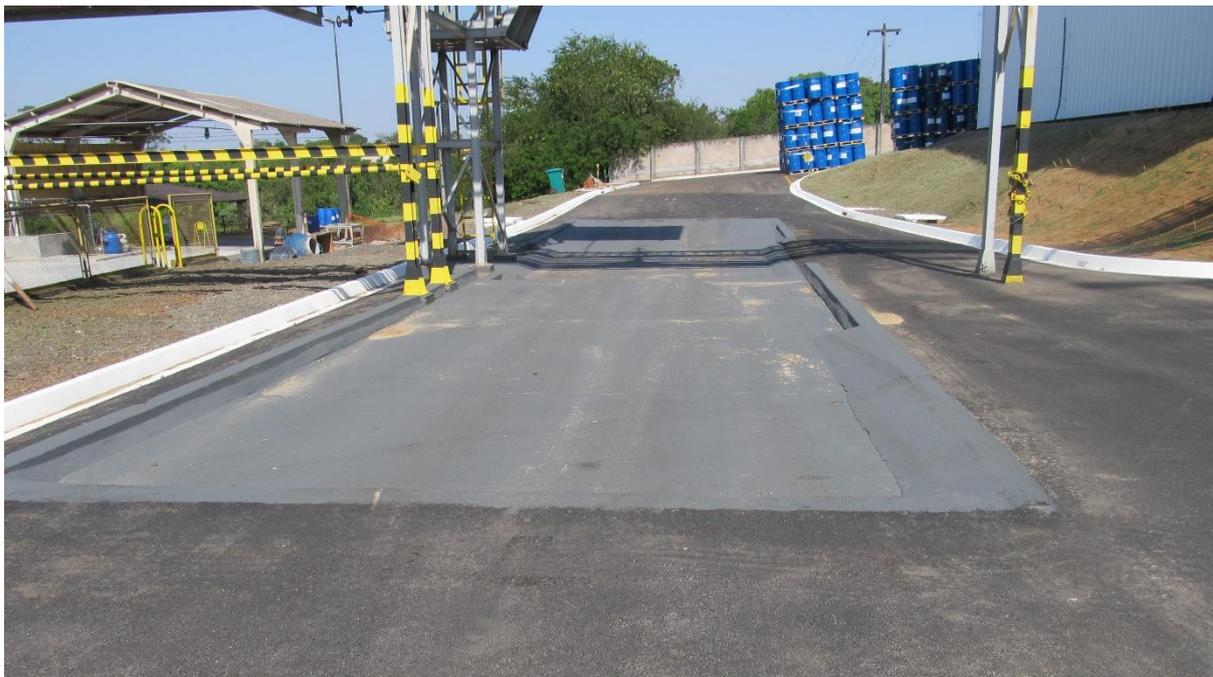
**Figura 4.5 – Contenção para isolamento de percurso de líquidos químicos.**
