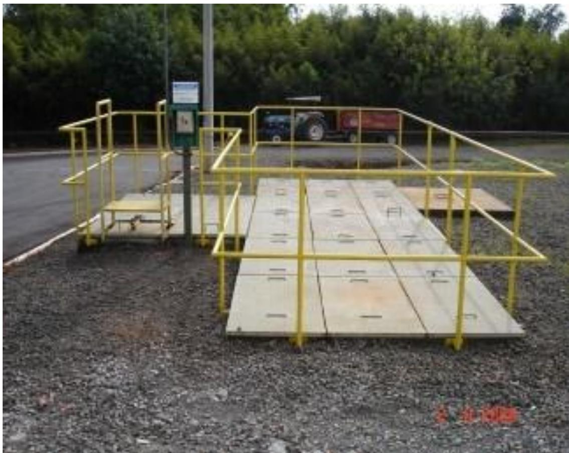
Figura 4.15 – Sistema de bacias de emergência para contenção de águas pluviais.
